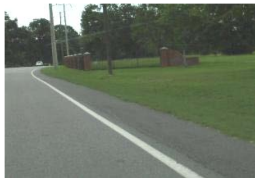
Robins Pkwy, Asphalt Bike Path
